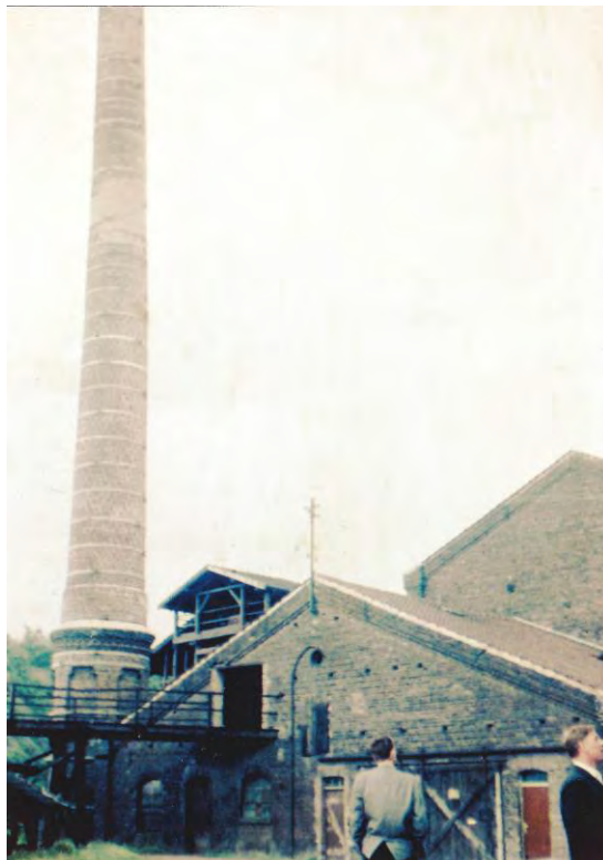
Abb. 29: Schornstein und Kesselhaus von Norden. Um 1960 wurden Ringofen, Schornstein und Trockenhaus abgebrochen. (Dr. Bernd Grabe/Peter Wilschewski)
