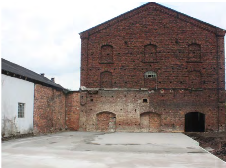
Abb. 33: Das Kesselhaus - letztes Betriebsgebäude - im Umbau, von Süden, 2017 (Tilo Cramm)
