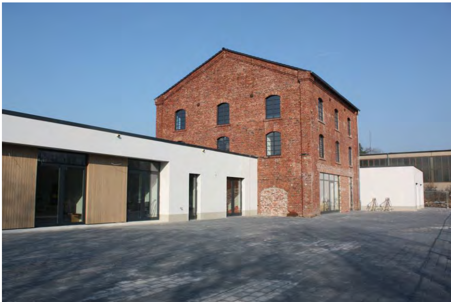
Abb. 37: Der fast vollendete Umbau von Südosten, März 2018 (Tilo Cramm)
