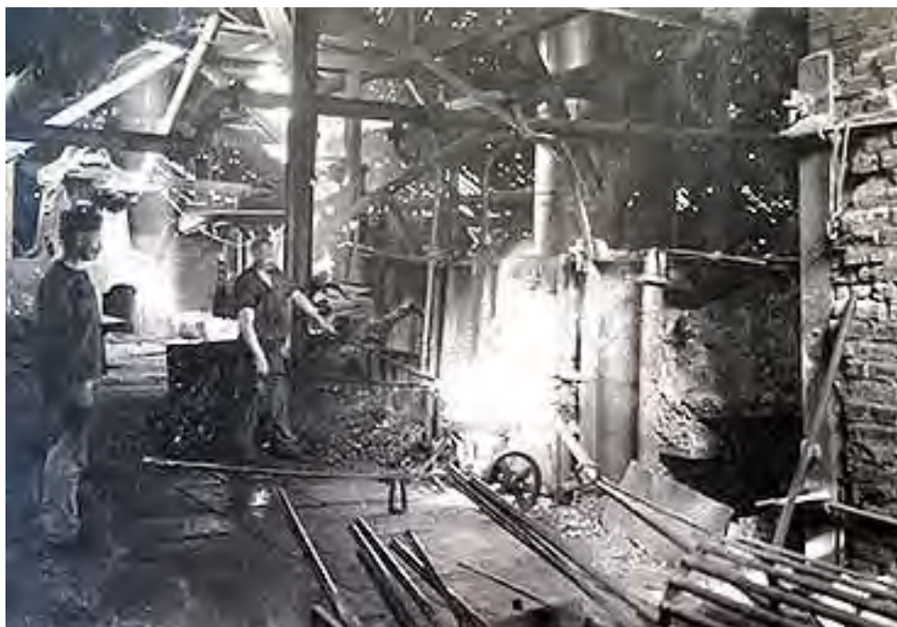
Abb. 3: Ein Puddler zängt eine ca. 50 kg schwere Luppe aus dem Ofen und legt sie in eine Karre. (Krupp-Archiv, Essen)
